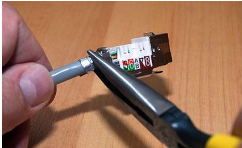
شكل رقم ١٢٥: عملية تثبيت وصلة التأريض (Shielding)
