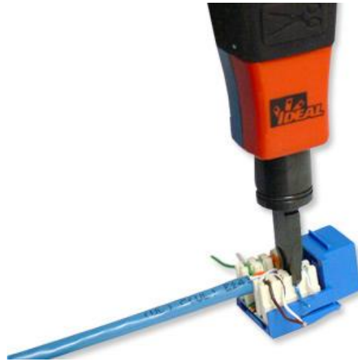
شكل رقم ١١٢: عملية تدبيس السلك في المكان المخصص
