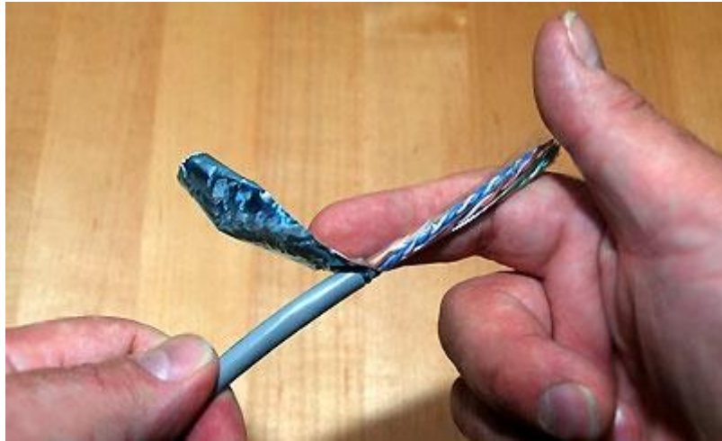
شكل رقم ١١٨: ثني الغلاف المعدني (Shield) الداخلي
