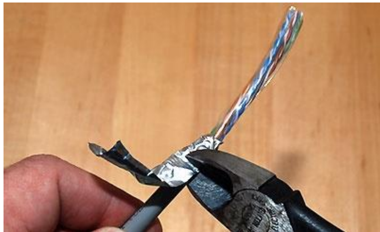
شكل رقم ٩٦: قص الزائد من الغلاف المعدني (Shield) الداخلي
